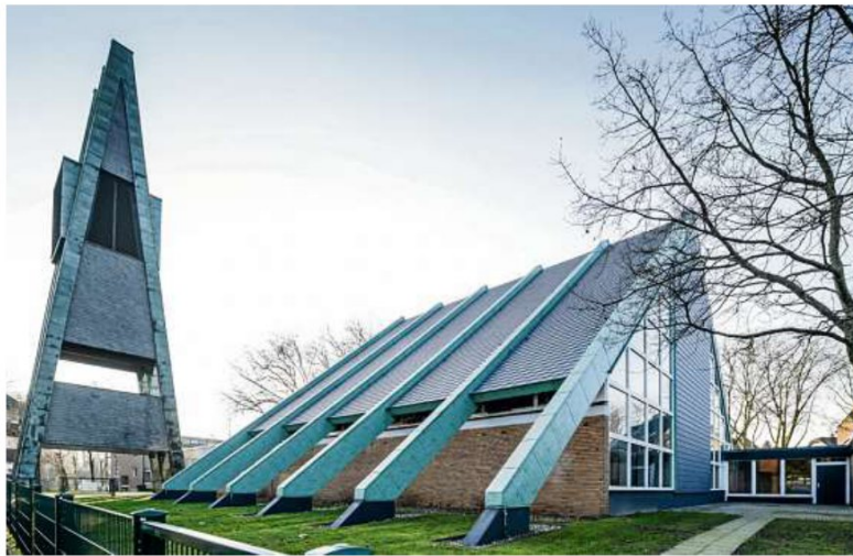
Neue Zeiten für fünf evangelische Gemeinden. Hier die Kreuzkirche an der Wörthstraße in Friemersheim.
